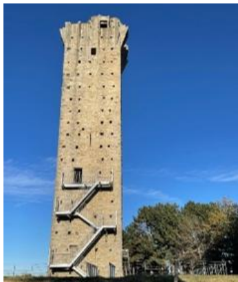
Torre di Vengore
